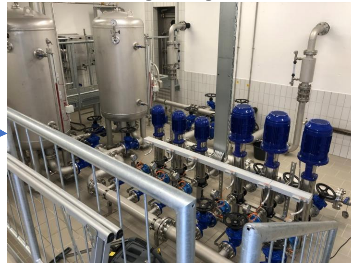
Druckerhöhungsanlage
